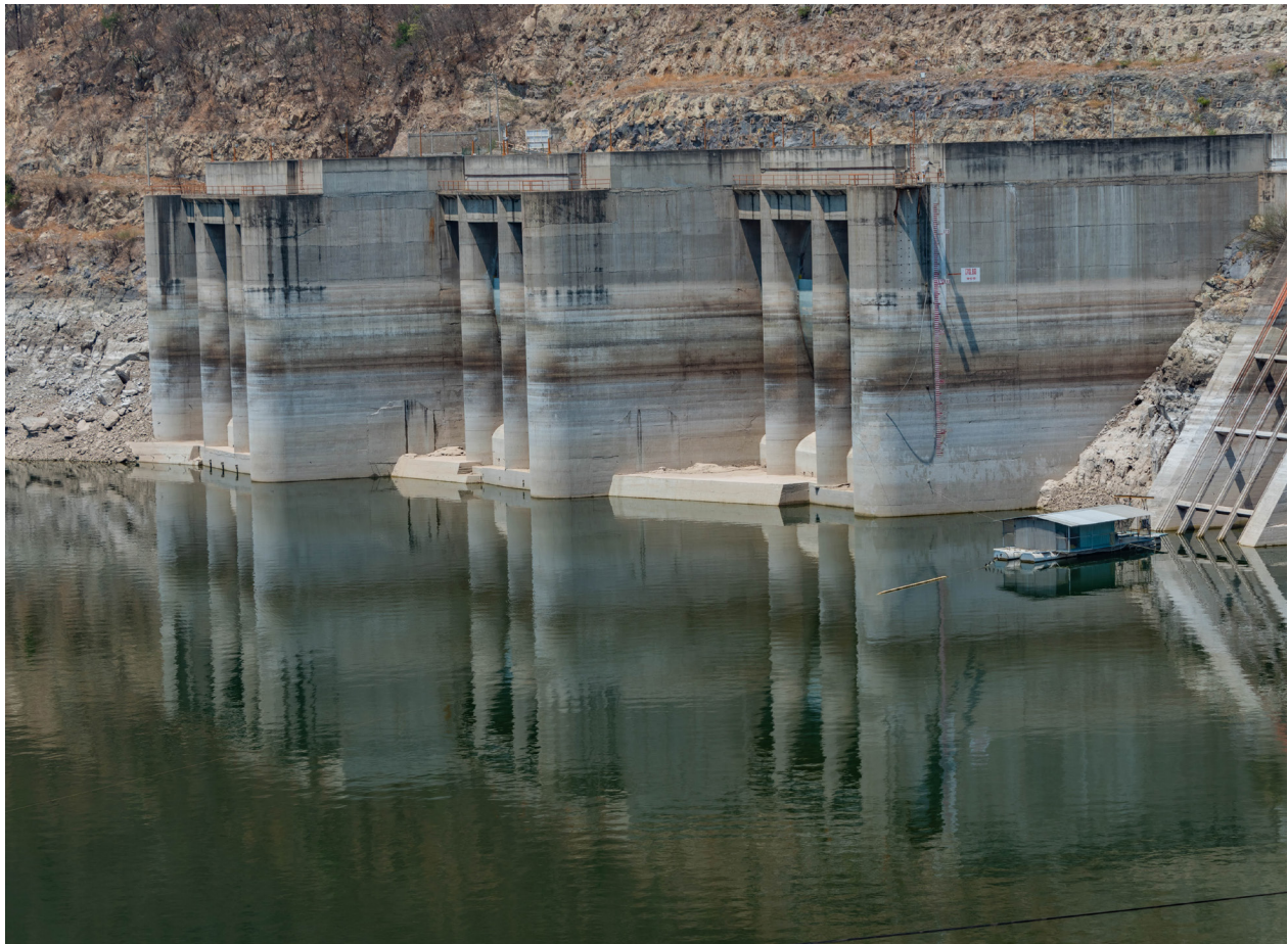
Central hidroeléctrica, Arteaga, Michoacán. Comisión Federal de Electricidad.
