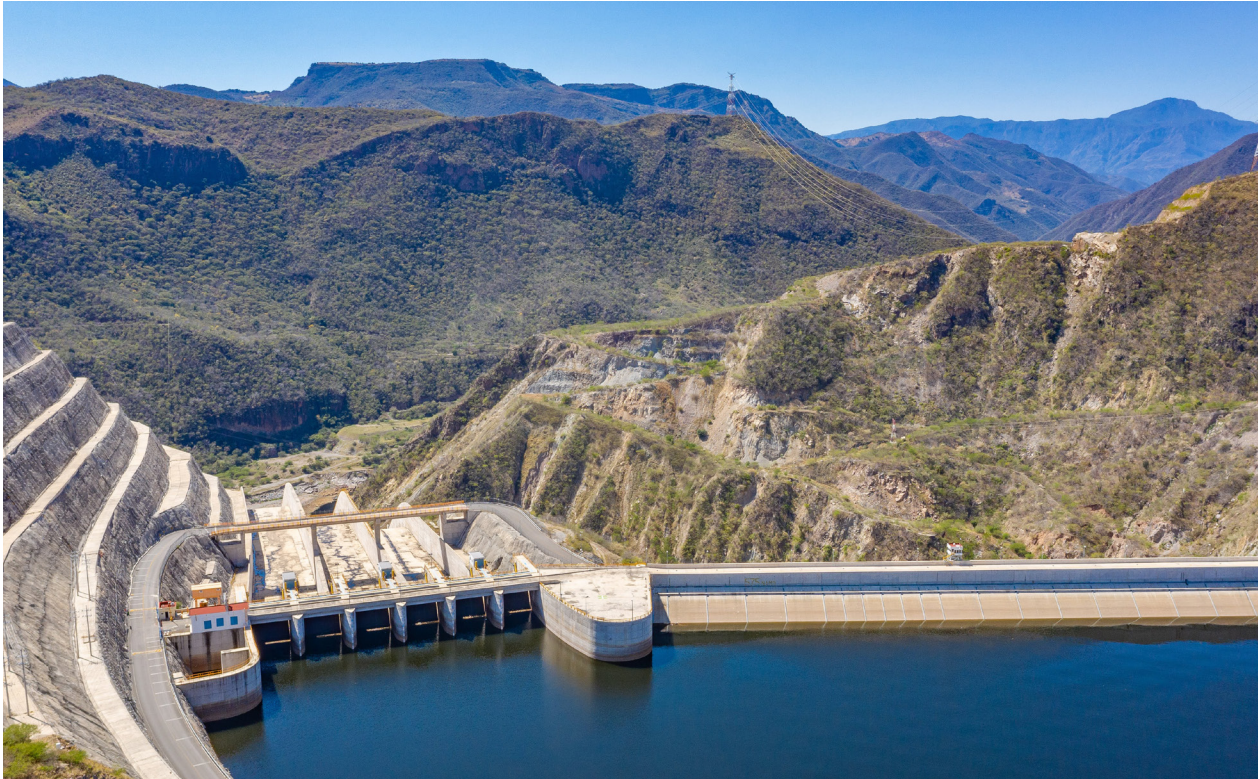
Central hidroeléctrica, La Yesca, Nayarit. Comisión Federal de Electricidad.
