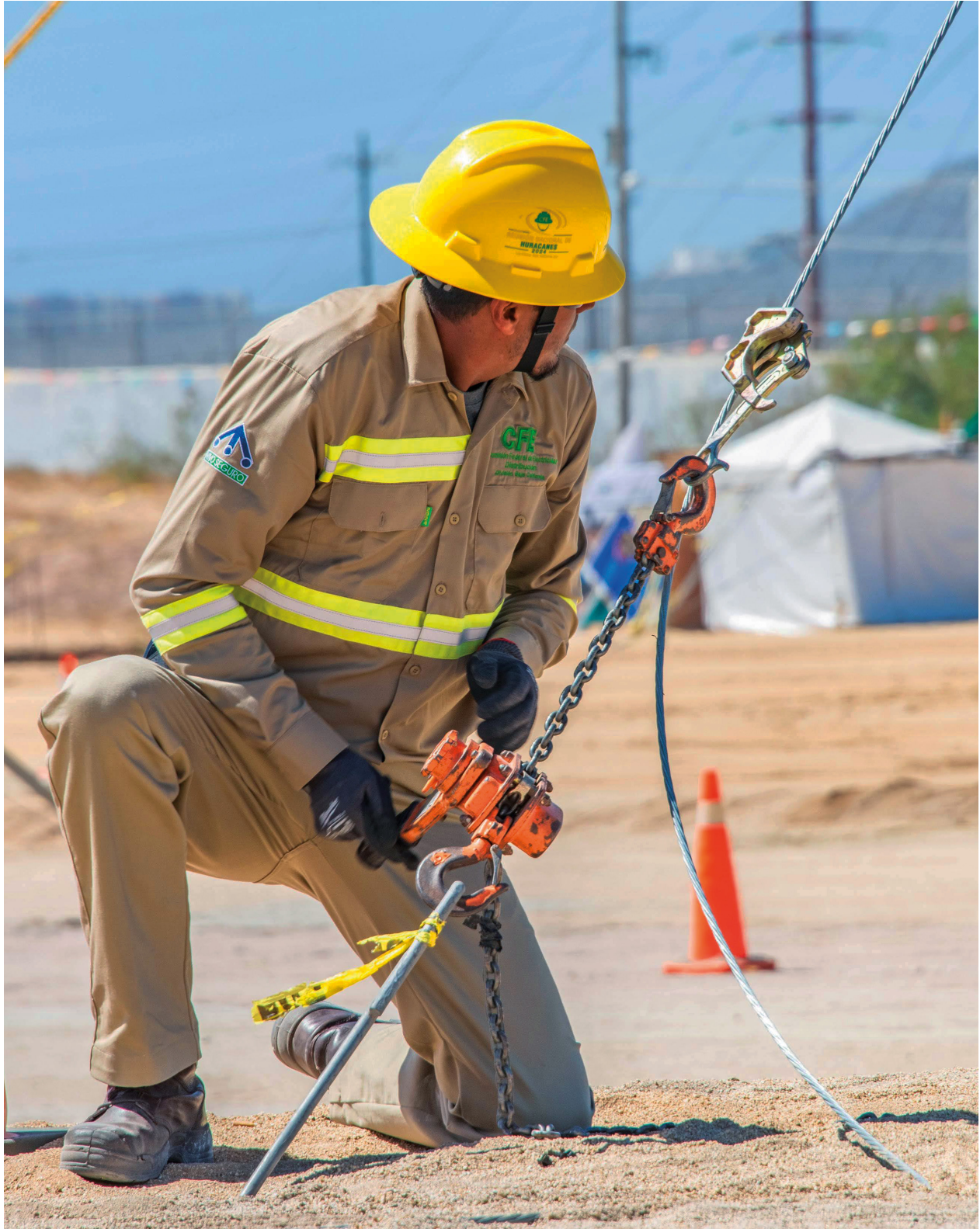
Ejercicio de maniobra durante el izaje de estructura de emergencia. Reunión Nacional de Huracanes 2024, Los Cabos, Baja California Sur. Comisión Federal de Electricidad.
