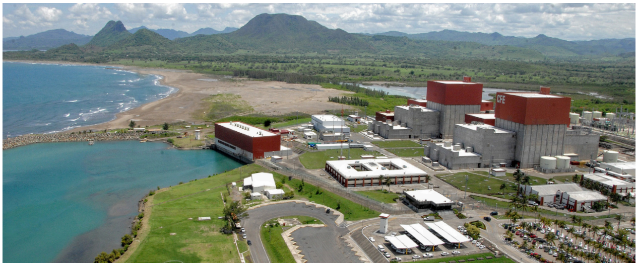
Central nucleoelectrica , Alto Lucero de Gutiérrez Barrios, Veracruz. Comisión Federal de Electricidad.
