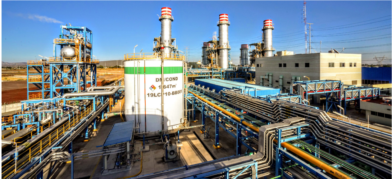
Central de Cogeneración, Salamanca, Guanajuato. Comisión Federal de Electricidad
