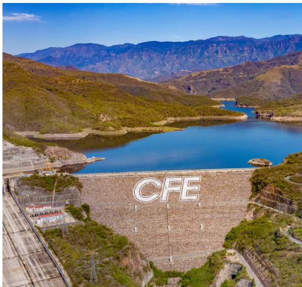
Central hidroeléctrica, Santa María del Oro, Nayarit. Comisión Federal de Electricidad.
