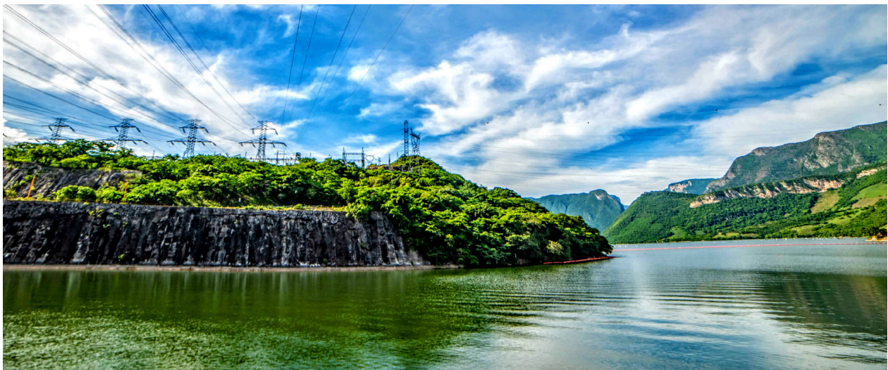
Central hidroeléctrica, Chicoasén, Chiapas. Comisión Federal de Electricidad.
