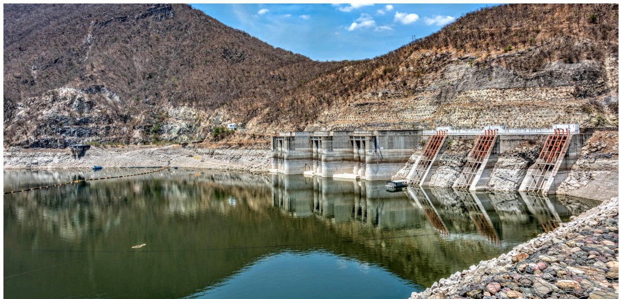
Central hidroeléctrica, Coahuayutla de Jose María Izazaga, Guerrero. Comisión Federal de Electricidad.
