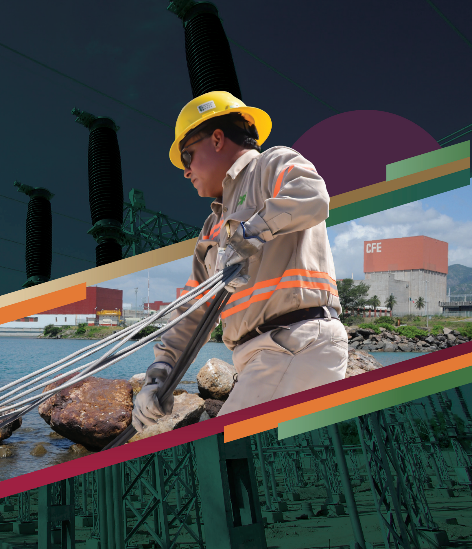
Subestación eléctrica, Tuxpan, Veracruz. Central nucleoelectrica, Alto Lucero de Gutiérrez Barrios, Veracruz. Comisión Federal de Electricidad.
